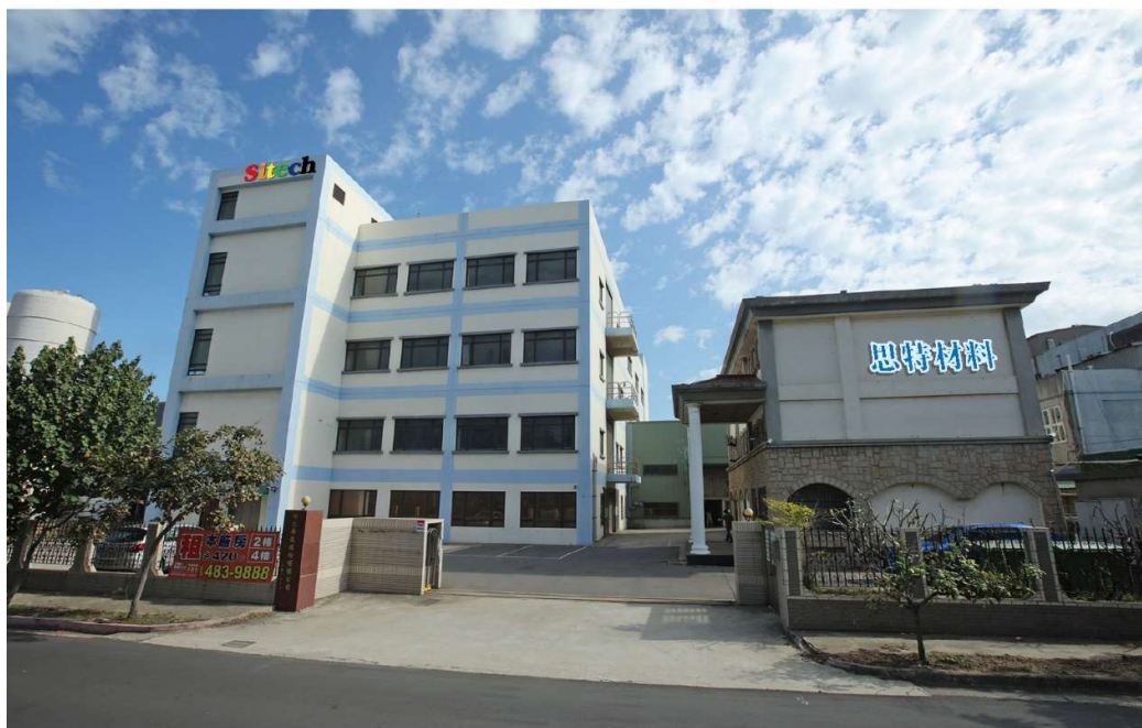
Taoyuan Factory | 桃園工場
